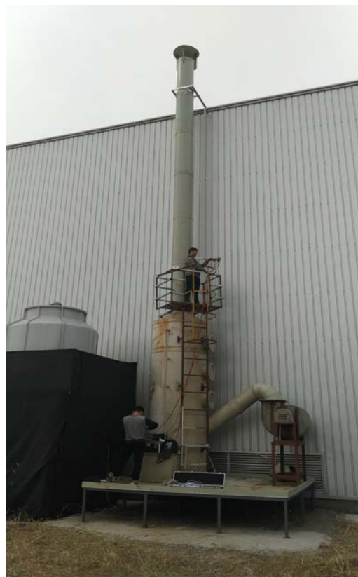
两条镀锌生产线配套的酸雾吸收塔及废气排放口
