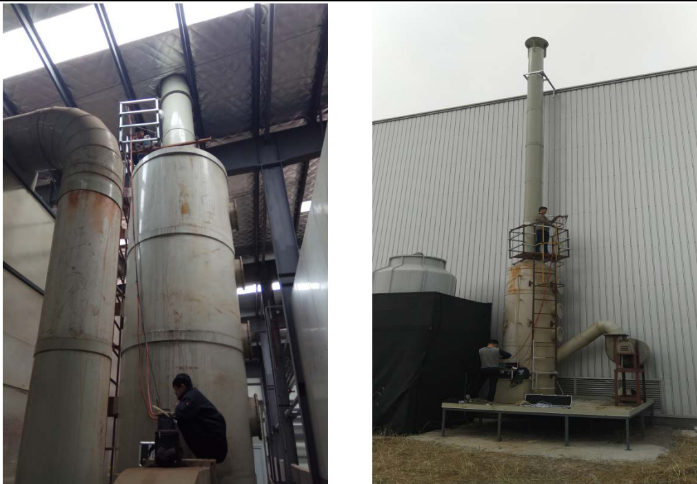
有组织废气采样现场照片
