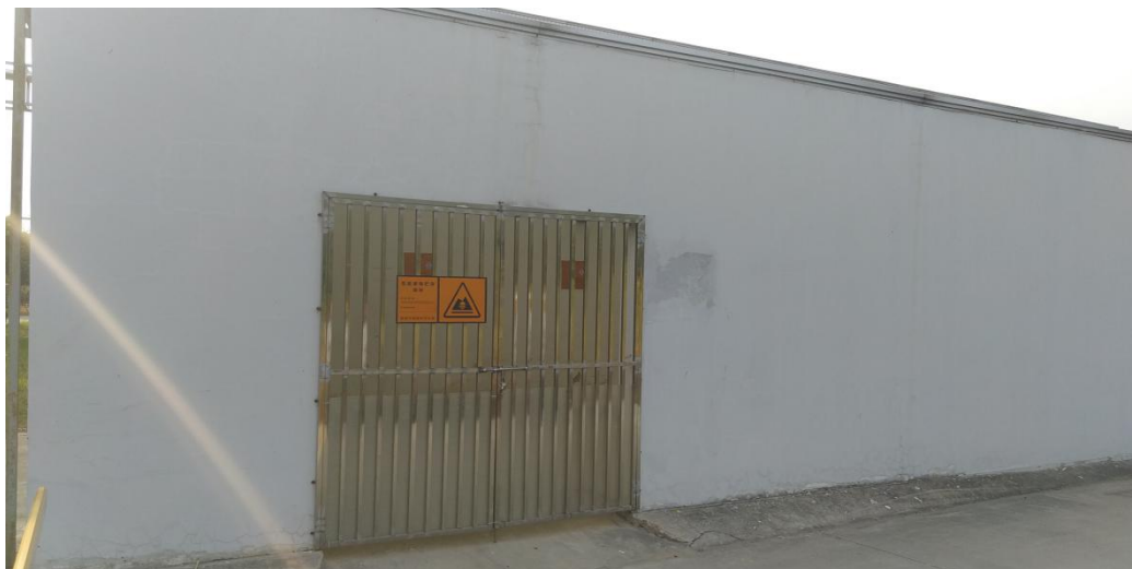
危险废物暂存间
